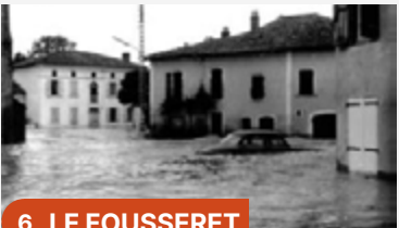
6 LE FOUSSERET Crue de la Louge - Juillet 1977 À la suite d'une crue exceptionnelle, le hameau de Benque se retrouve inondé, comme l'ensemble de la vallée de la Louge
